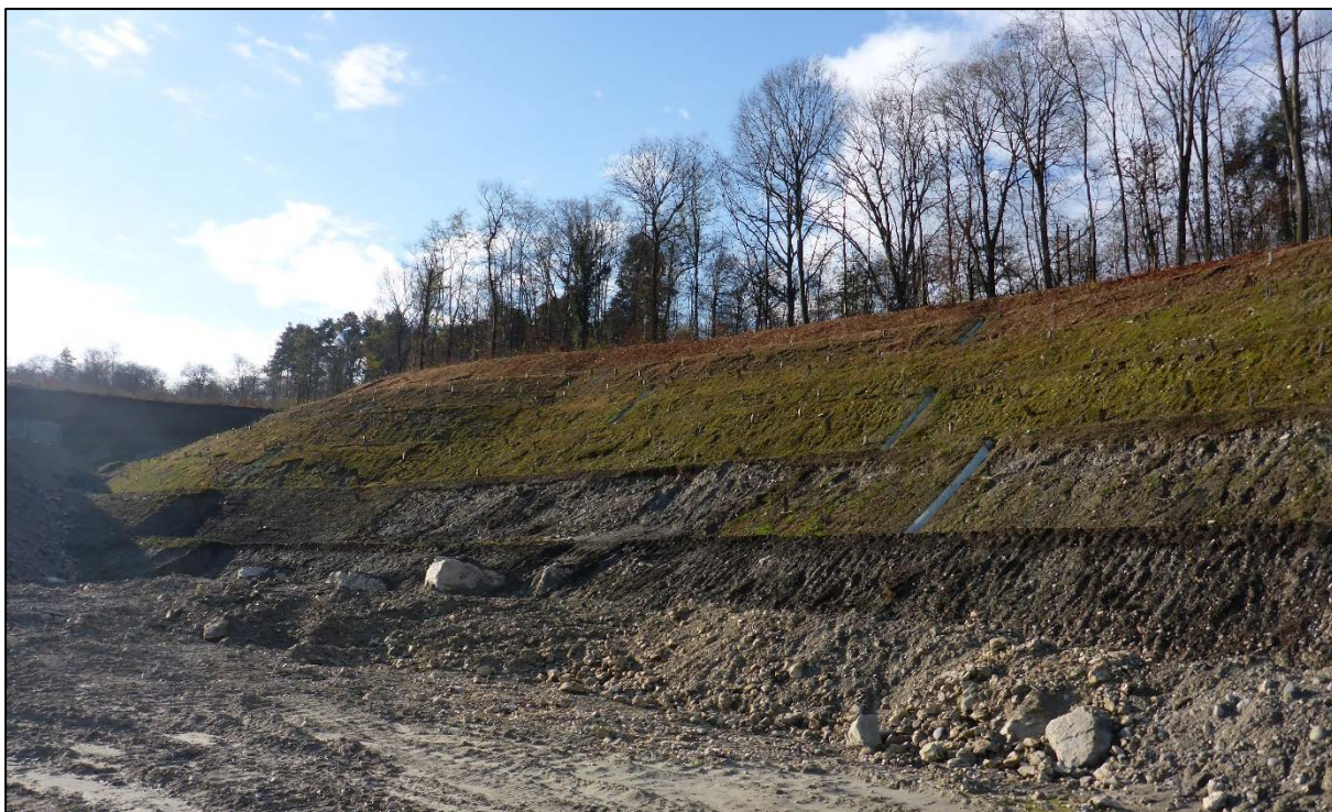
Figura 4.4 – Fronte lato est della miniera, gradoni di recupero ambientale del deposito sciolto ubicato nella porzione più elevata della fossa.
