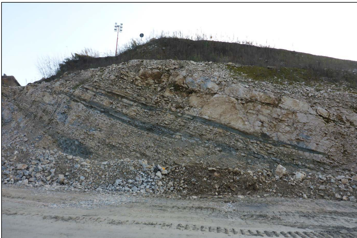
Figura 4.3 – Fronte lato sud della berma a q.330 m s.m., si notano bene gli interstrati marnoso argillitici.
